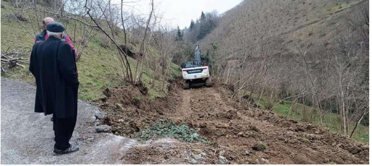
Köylerimizde yeni yol çalışmalarımız.
