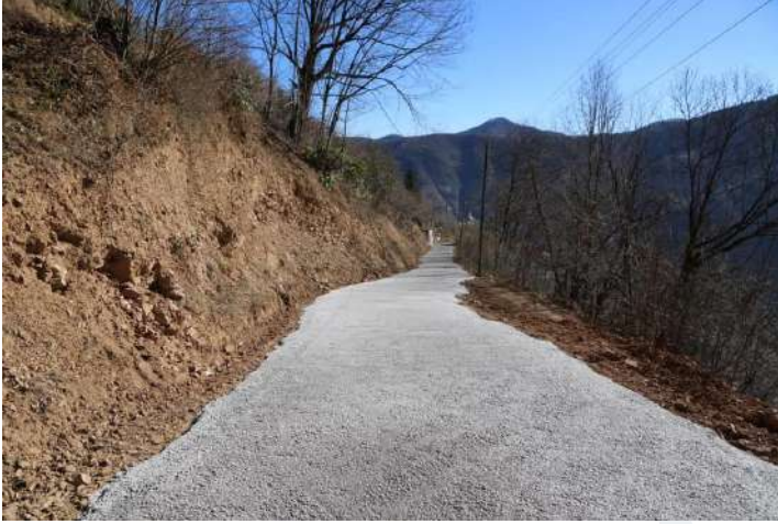
Köy yollarını betonlama çalışmalarımız.
