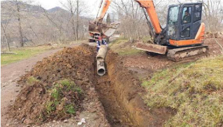
Köy yollarına beton büz ve düzenleme çalışmalarımız
