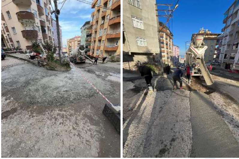
Sancak Mahallesiinde betonlama alıřmaları yapıldı.
