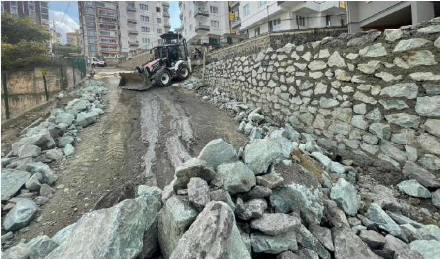
Duvar yapımı çalışmalarımız
